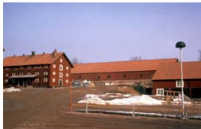
Ekonomibyggnader vid Lantbrukshögskolan, Ultuna, 1972
